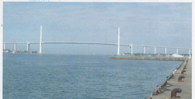
写真2 完成間近の新湊大橋（2012.02.29）
